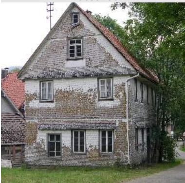
Gesteinsmahlhaus vor der Sanierung durch den Verein
