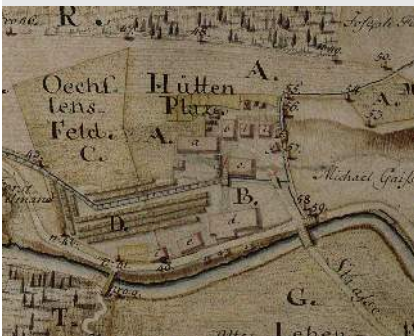
Der Holzlagerplatz der Glashütte mit dem Triftholzkanal, durch den die Glashütte ihr Brennholz herbeitrifete
