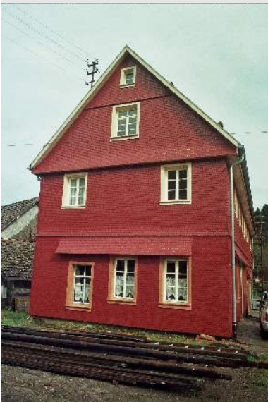
Gesteinsmahlhaus nach der Sanierung durch den Verein. Die rote Farbe und auch die Fensterlaibungen sind nach Befund gestrichen. Das Haus hieß einst: „Das rote Haus“
