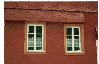
Typisches Detail, heute ganz vergessen. Ein Vordach zum Schutz der einst wertvollsten Bauteile: Fenster : Auch dies gehört zum Thema Glas
